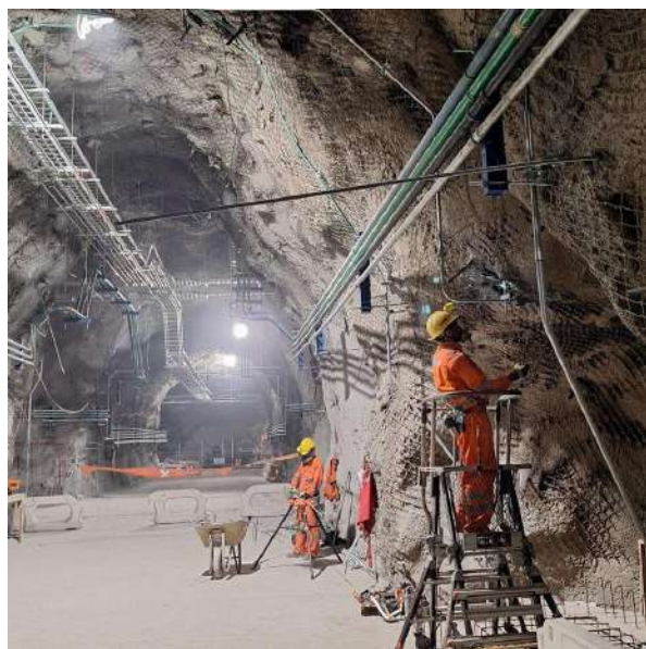
Faena subterránea y cableado eléctrico.
