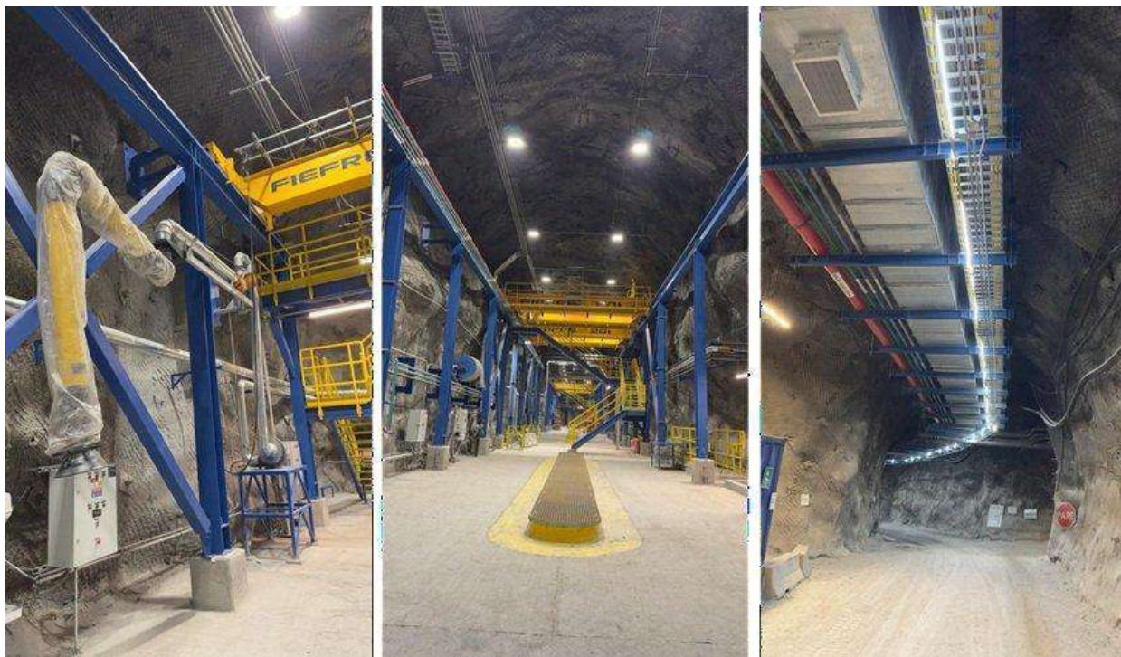
Instalaciones eléctricas subterráneas completadas — tuneladoras, alumbrado industrial y bandeja de cables en túnel de la División El Teniente.
