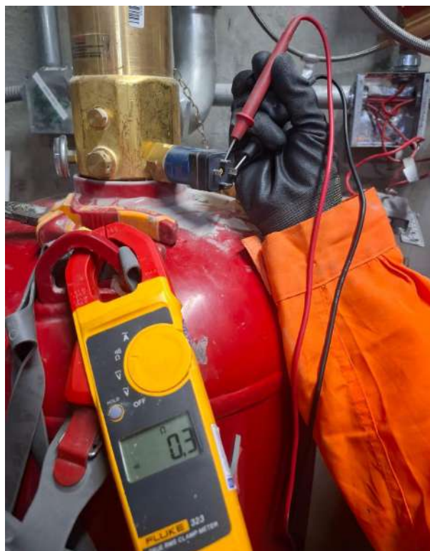
Técnico FEN verificando solenoide de cilindro con multímetro Fluke 323 durante puesta en marcha.
