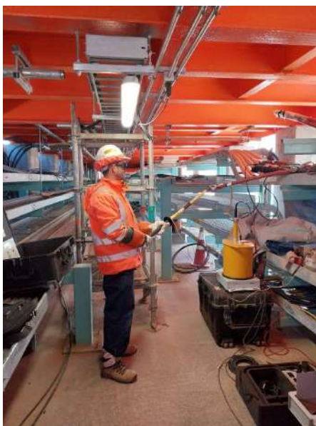
Técnico FEN ejecutando prueba VLF en cables MT en instalación interior.
