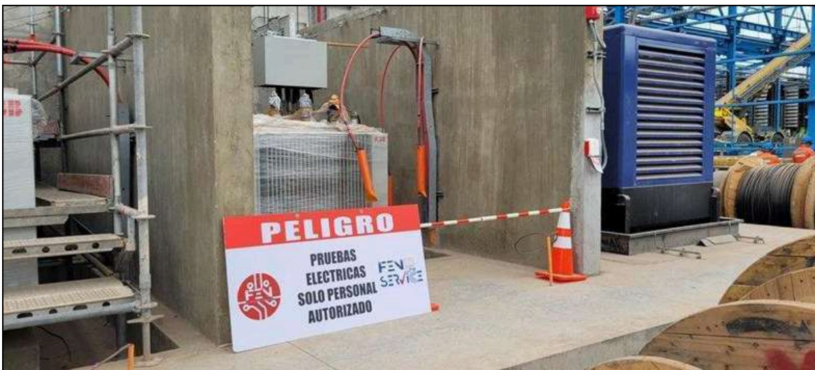
Zona de pruebas eléctricas de cables en terreno - Planta Desaladora Aguas Antofagasta.
